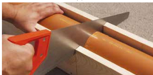
Obrázek 2 Zkracování trubky pilkou
